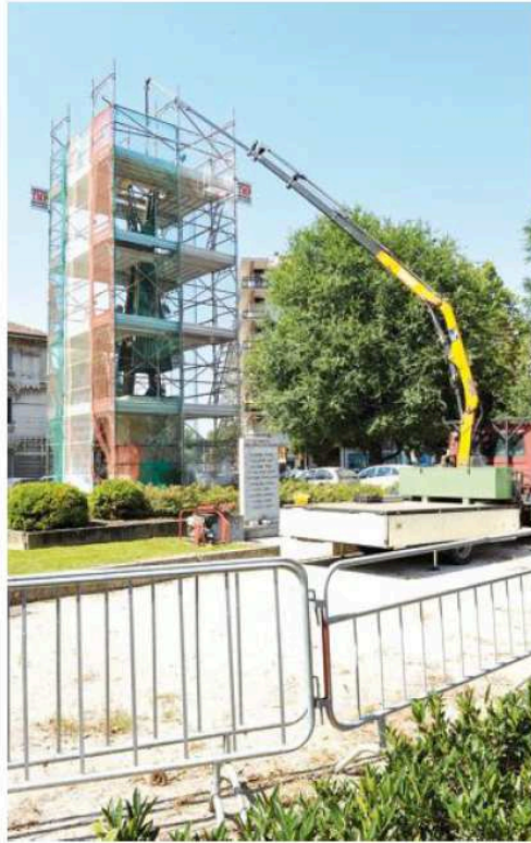
IL BELFAGOR | I lavori del 2012 per smantellare la statua danneggiata
